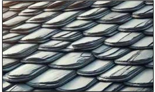
*Die Illustration zeigt ein Beispiel für die Alteutsche Deckung eines Dachs.*
